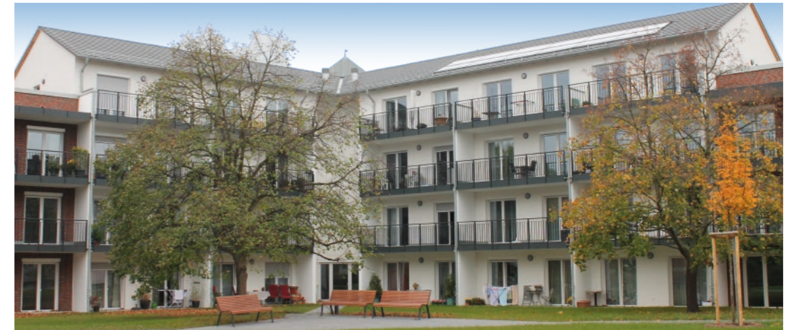
Das in 2011 begonnene Neubauprojekt in der Mozartstraße 18 mit 25 Wohnungen für die Generation 50+ wurde 2013 fertiggestellt.
