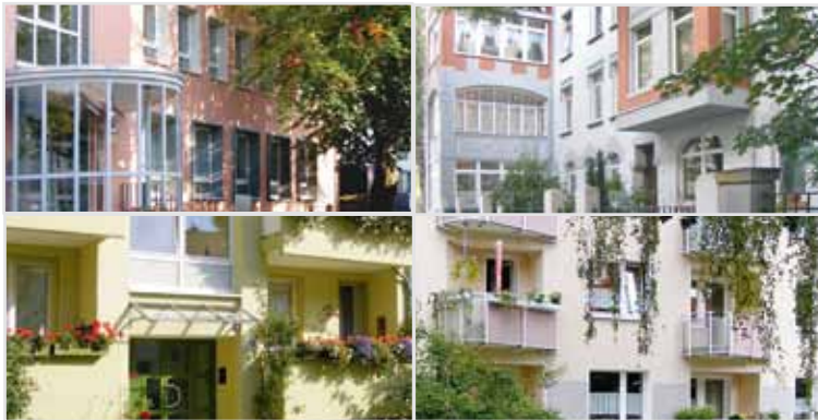
Bürogebäude Am Jungfernplan (links oben) und die Wohnhäuser an der Jacobsstraße, dem Flebbeweg und der Stenhusenstraße.
