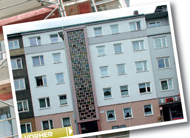
Die Fassade von 2002 war stark verschmutzt.
