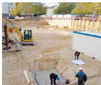
Inzwischen ist in Stöcken die Baugrube ausgehoben und der Keller entsteht.
